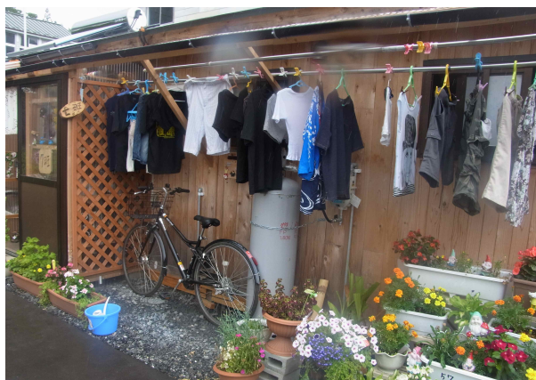
木の温もりと生活感の溢れる住田町の仮設住宅
